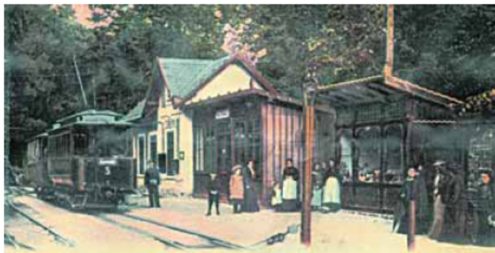
Tramvaje jezdily od roku 1895 z Teplíc až do horního Dubí v Krušných horách, kde se nacházela konečná stanice. Snímek zachycuje, jak to tady vypadalo v roce 1905. V roce 1911 nedaleko odtud v lesním svahu vykolejila tramvajová souprava a převrátila se, přičemž 18 lidí utrpělo těžká zranění.
