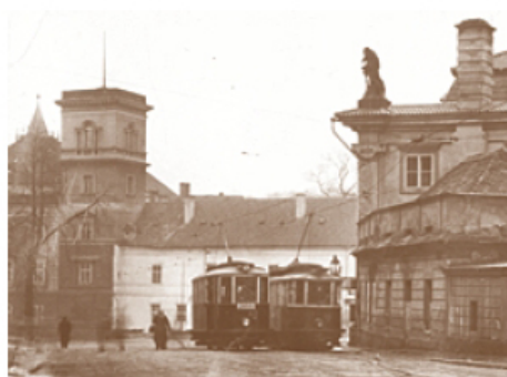
Tratě teplických tramvají byly původně postavené jako jednokolejné s příslušnými výhybkami na určitých zastávkách. Na snímku z doby po roce 1945 spatříme křížování tramvajových vozů před Zahradním domem v Teplících.
