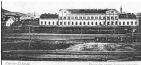
Pohled na kolejiště s perónem teplického hlavního nádraží směrem od severu pochází z prvních let 20. století, kdy už Ústecko-teplická dráha sloužila provozu dobrých 45 let.
