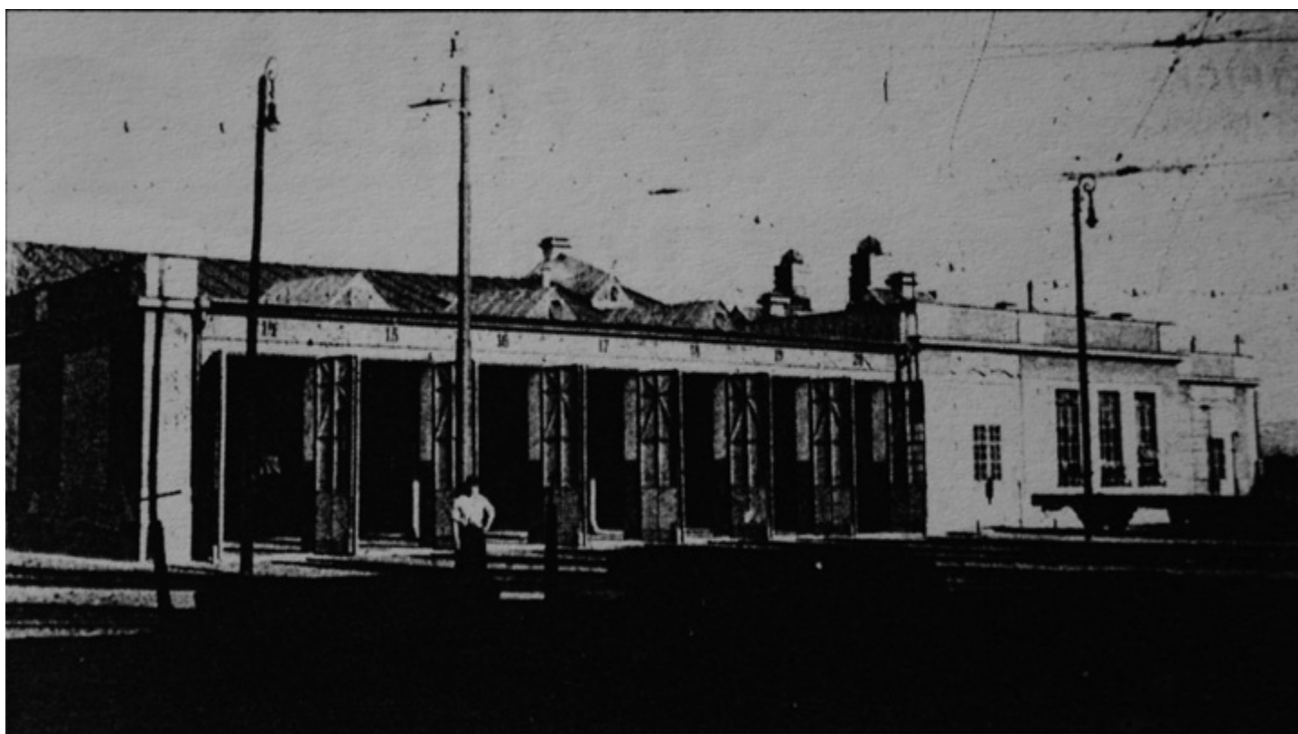
Firma Linheim a spol. se ujala stavby nejen tratí, ale i vozovny. Na snímku vozovna na Novém mlýně – dnes Dopravní podnik. Na místě bývalé remízy elektrických tramvají jsou dnes garáže a opravný autobusů.
