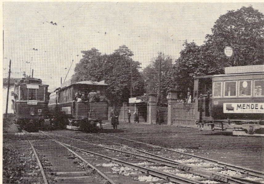
VOZY TEPLICKÉ ELEKTRICKÉ DRÁHY U ZASTÁVKY NOVÝ MLÝN — DNES ZDE SÍDLÍ DOPRAVNÍ PODNIK MĚSTA TEPLICE
